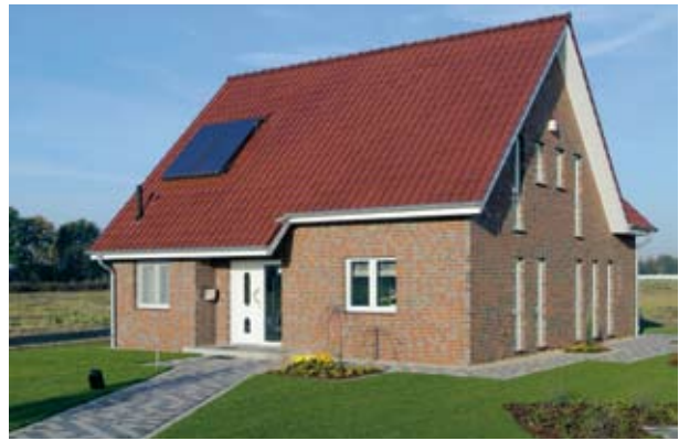
Haus Bremen House Bremen
