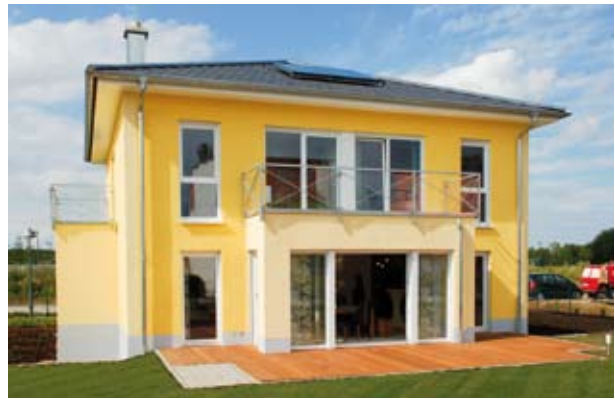
Haus Strasbourg House Strasbourg
