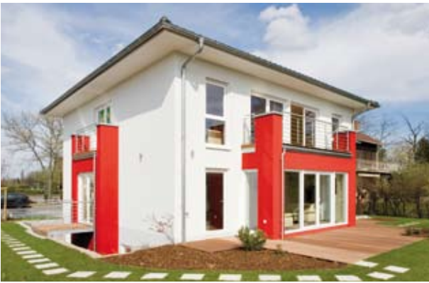
Haus Strasbourg House Strasbourg
